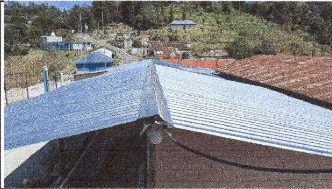
Foto 1: Sustitución de lamina por lámina troquelada aluzinc calibre 26
