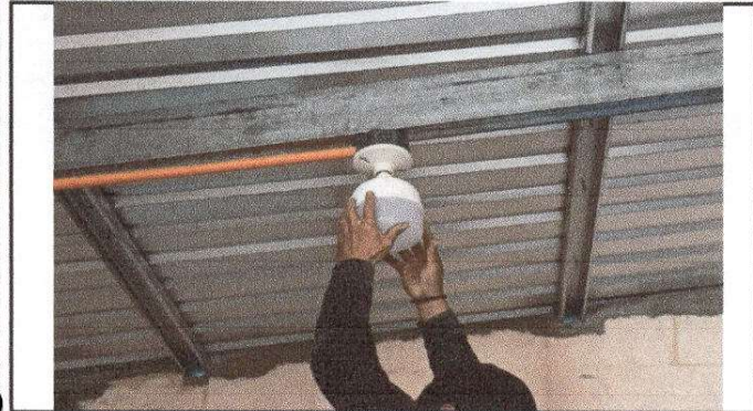
Foto 7: Sustitución de focos ahorradores
