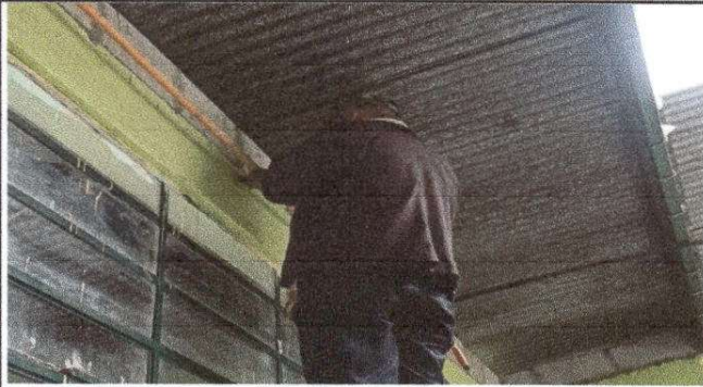
Foto 13: Sustitución de ducto eléctrico y accesorios
