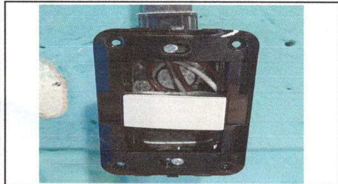
Foto 9: sustitución interruptores simples
