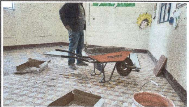
Foto 14: Sustitución de piso de granito
