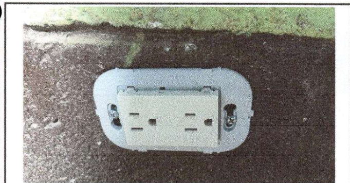
Foto 11: sustitución de tomacorrientes dobles
