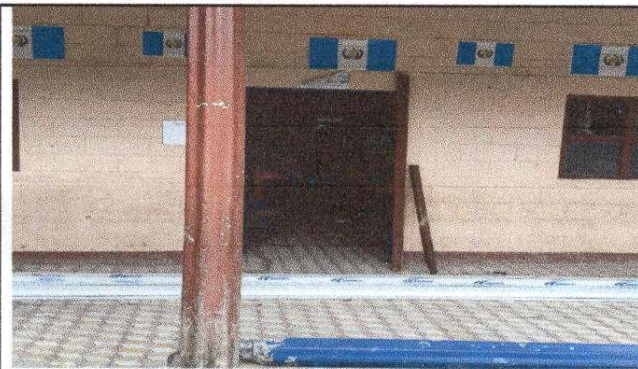
Foto 3: sustitución de puerta
