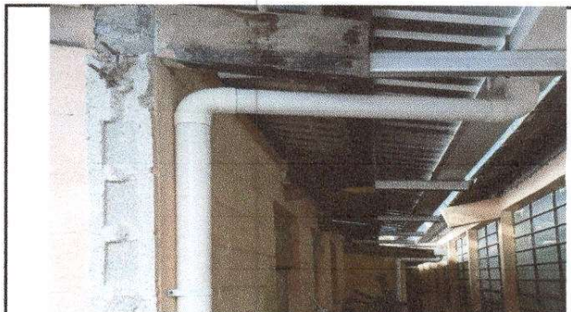
Foto 6: bajadas de agua pruvial de metal ppr tubo PVC
