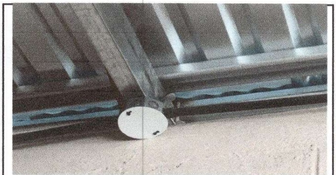
Foto 12: Sustitución de cableado eléctrico
